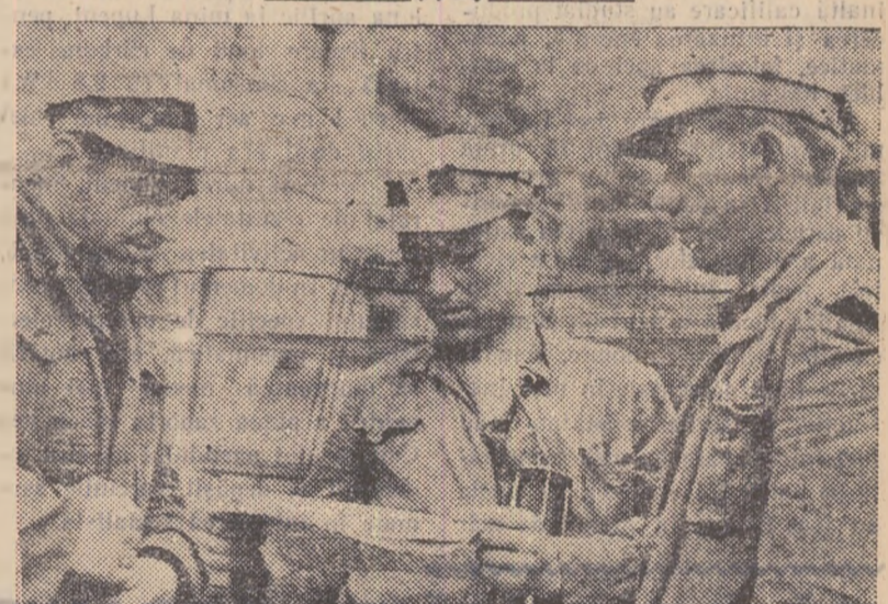
În luna mai lucrînd în bună măsură numai din ciocan de abataj brigada lui Velek Ioan din sectorul I A al minei Lupeni a excavat mai bine de 53 m. de galerie. ÎN CLIȘEU: Minerii Flaișer Mihai, Molnar Adalbert și Divniceanu Ioan din brigada lui Velek Ioan discută înainte de intrare în șut asupra părții din proiectul de Directive ale celui de-al III-lea Congres în care vorbește de necesitatea creșterii avansărilor în lucrările miniere.
