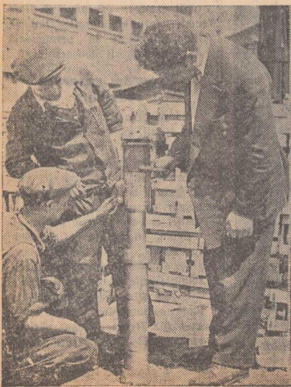
Inzestrarea tehnică a minei Lupeni sporește continuu. Acum citiva timp minerii de aici au primit o combina pentru înaintări tip P.K. 3, iar recent citeva sute de stîlpi de susținere specialați pentru stratele subțiri. ÎN CLISEU: Muncitorii Duban Anton și Mișik Alexandru cercetează împreună cu ing. Andrașche Vasile modul de funcționare a sistemului hidraulic al stîlpilor metalici sosiți la mină.
