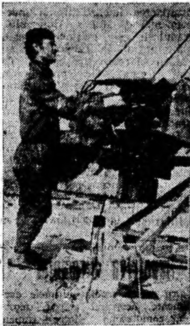
Mecanicul Petrișor Gheorghe, care lucrează ca manipulant la o macara cu braț, se numără printre constructorii fruntași de la cartierul nou Livezeni. Iată-l în clișeu nostru, manipulînd trolul macaralei care ridică la înălțimi mortarul, contribuînd la construirea cit mai rapidă și în bune condiții a blocului 1 A.
