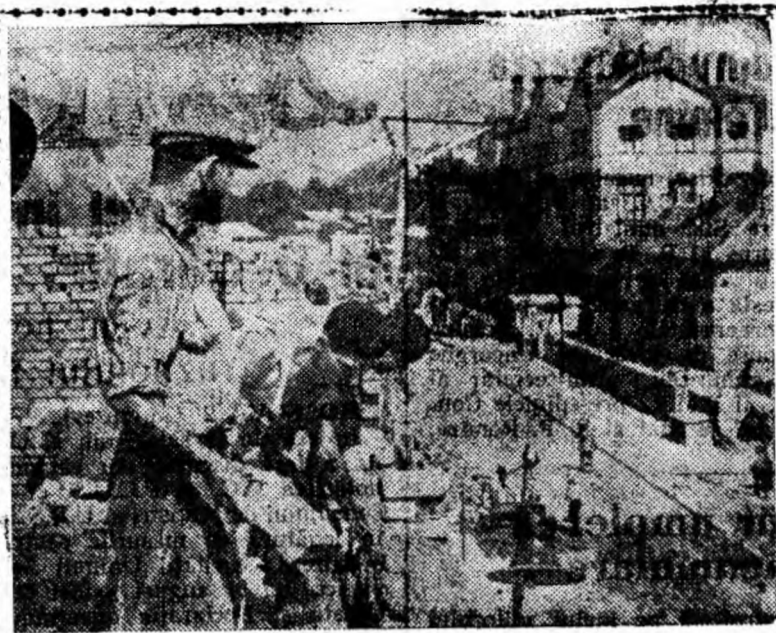
Zidirea celui de-al treilea etaj e pe sfîrșite. Constructorii care lucrează la înălțarea noilor blocuri de pe strada C. I. Parhon muncesc cu avînt. IN CLIȘEU: O echipă de zidari în timpul lucrului.
