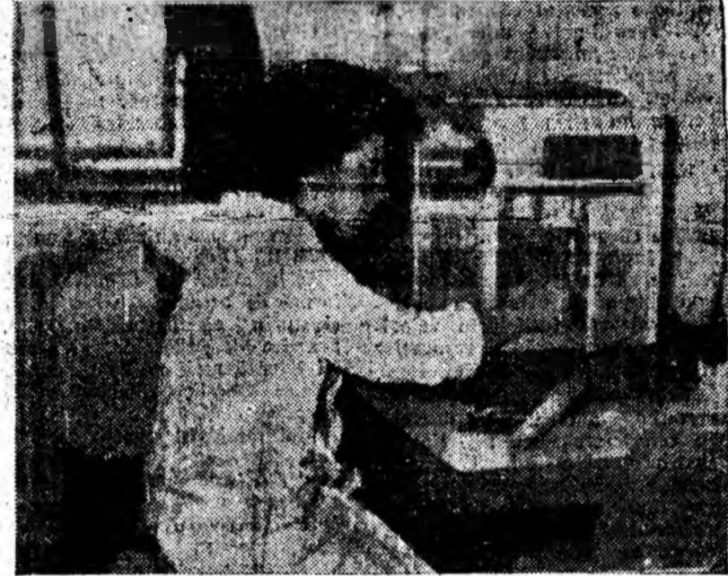
În secția chimică a termocentralei Paroșeni — secție fruntașă pe întreprindere — există o sală unde nu se intră numai cu pașul de casă. În această sală denumită a balanțelor se determină puterea calorică a cărbunelui folosit drept combustibil.
