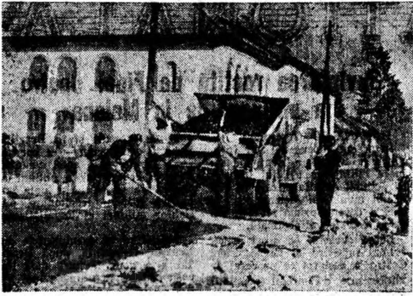
Patru kilometri șosea asfaltată — este realizarea deosebit de frumoasă obținută anul acesta de constructorii loșului Petrila. Incepând asfaltarea din dreptul ștrandului Petrila, brigada de asfaltatori a lui Stoica Ilie a ajuns cu asfaltatul până sus în dreptul restaurantului „Cărbunele” din Lonea. IN CLIȘEU: Brigada lui Stoica Ilie turnând asfalt în centrul Lonei.
