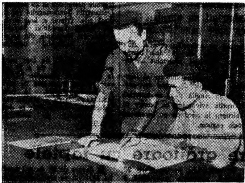
Dragomir Gheorghe și Dinescu Chiriac sînt prieteni buni. Primul este șef de tură la turbină, iar celălalt, mecanic principal. Iată-l studiînd parametrii de funcționare ai agregatului nr. 1 din termocentrala Paroșeni.
