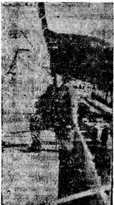
Fierarul betonist Horvath Ludovic montează armăturile la construcția amfiteatrului de la Institut.
