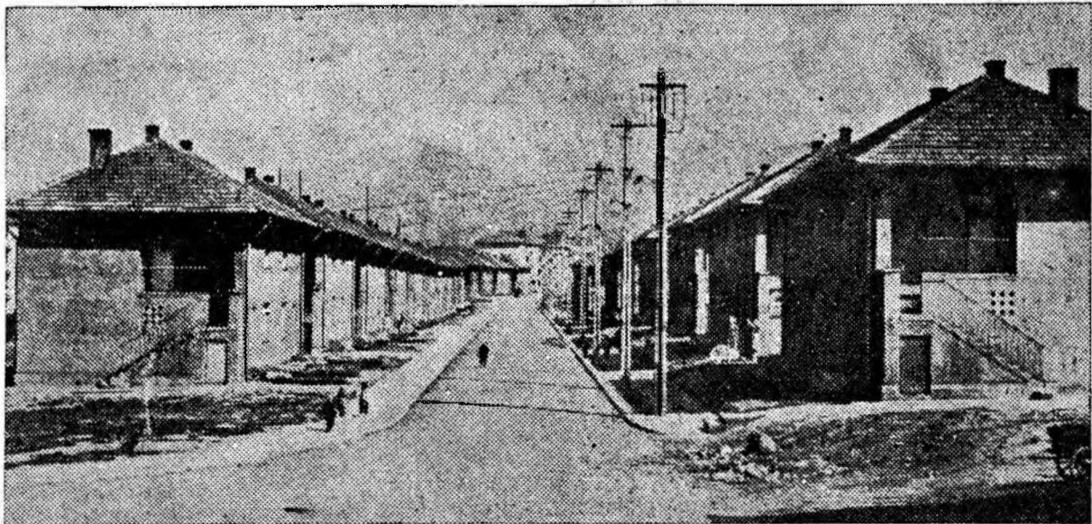
Cartierul Livezeni, cel mai tînăr cartier al Petroșaniului, crește continuu. Anul acesta, aici vor fi date în folosință alte cîteva sute de noi apartamente. Cliseul nostru înfățișează una din străzile noului cartier.
