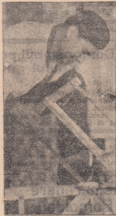
Echipa de dulgeri condusă de Cirstea Ioan execută lucrări de dulgerie de calitate în cadrul pregătirilor de iarnă de la mina Amnoasa.
