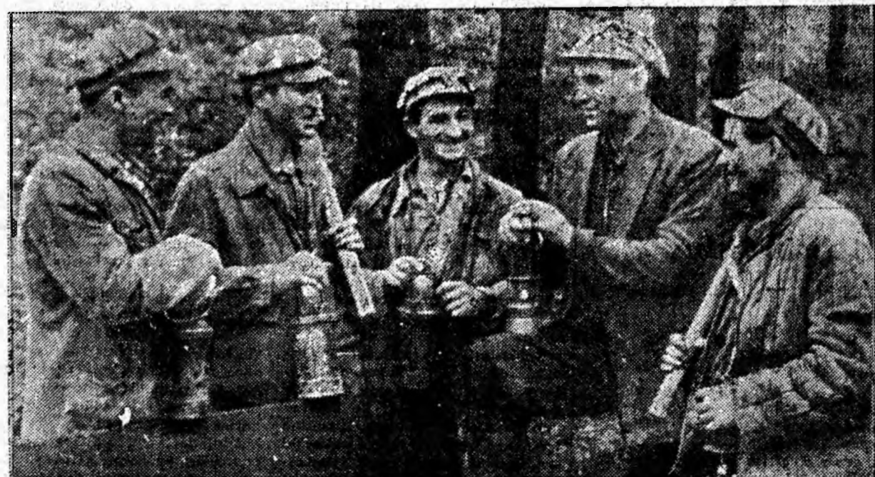
Brigada minerului Bardoș Victor efectuează de mulți ani lucrări de pregătire la mina Aninoasa. În prezent ea lucrează la lărgirea și betonarea galeriei de legătură cu puțul central sud unde realizează zilnic depășiri de plan.
