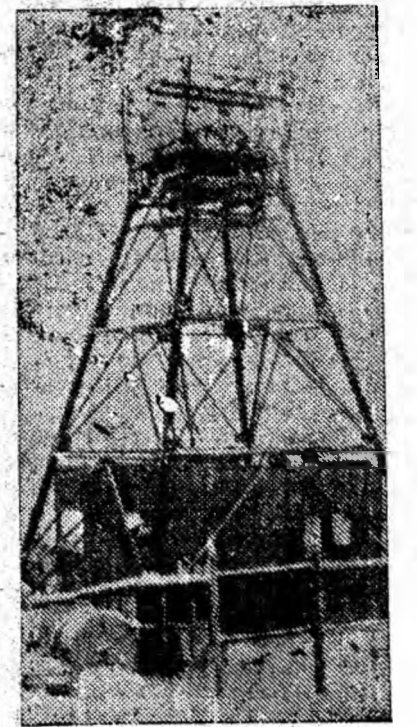
ÎN CLIȘEU: Vedere a puțului metalic pentru săpare.
