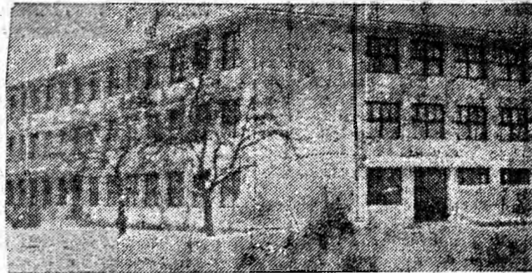
Școala nouă din Vulcan — a patra de acest tip din Valea Jiului — cuprinde 16 săli mari de clasă, două laboratoare și alte anexe necesare pentru buna desfășurare a procesului de învățămînt. Anul acesta, o asemenea școală va fi construită și la Lupeni, pentru copiii din cartierele Braia-Viscoza.
