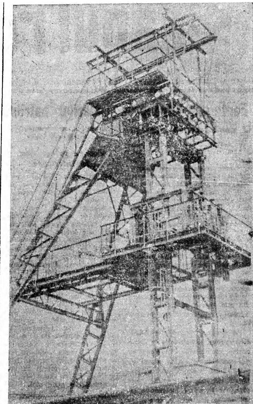
Mina Lupeni cunoaște o continuă dezvoltare. În ultimii doisprezece ani, aici s-au săpat 7 puțuri noi, au fost redeschise sau adăugate o serie de puțuri vechi. Între puțurile redeschise în ultimii ani se numără și puțul Carolina. Clîșeul nostru înfățișează construcția modernă a turnului metalic al acestui puț, executată de I.C.M.M. și dată nu de mult în folosință.
