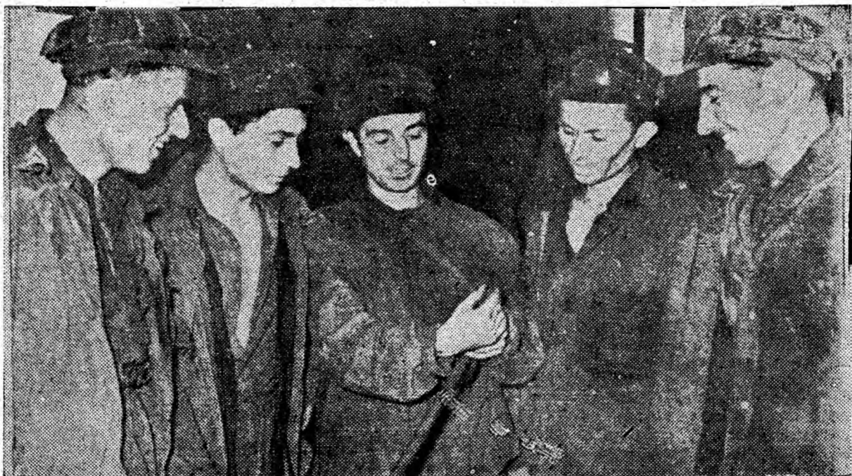
În abatajele unde se armează în lemn, secură este prieten nedespărțit al minerului. Dacă această sculă este bine ascuțită, șorolitul armăturilor se face mai ușor.
