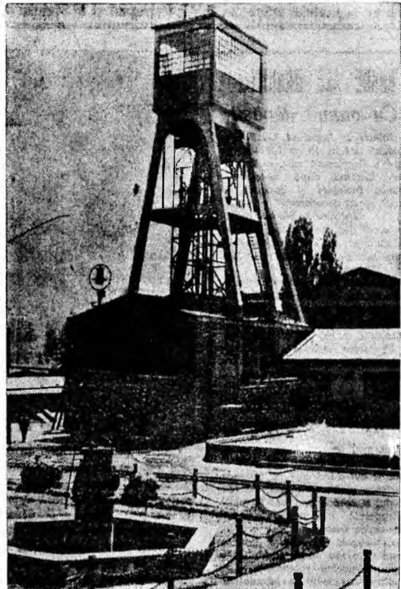
Turnul pușului Ștefan de la mina Lupeni. Pe acest puț se extrage la ziud o bună parte din cărbunele furnizat cocsării hunedoreni.
