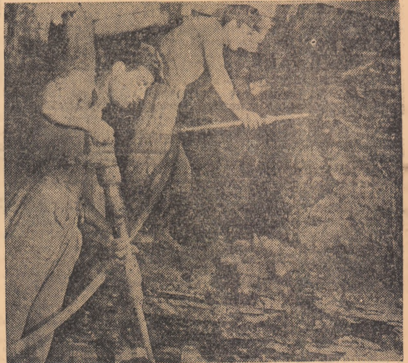
Șeful de brigadă Moloci Tudor (primul din stînga) lucrînd cu un ortac la excavații în galeria de coastă nr. 2.
