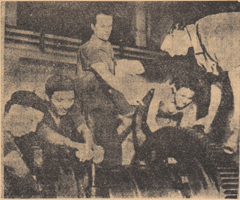
La termocentrala Paroșeni echipa de specialiști în reparații termomecanice condusă de Dolcu Vasile, a executat lucrări de revizie la cupele dintre turbine și generatoarele de energie electrică. Reparația a fost efectuată în jumătatea timpului prevăzut.
