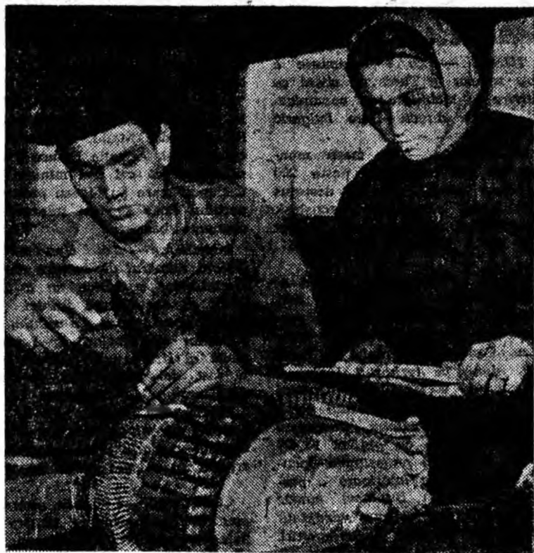
Bobinatorii Caraman Ștefan și Cristea Elena se remarcă la S.R.E. Vulcan prin lucrări de bună calitate. În luna septembrie a.c., ei au reparat înainte de termen patru motoare electrice de 23 kilowați. IN CLISEU: Caraman Ștefan și Cristea Elena recondiționînd rotorul unui motor electric.
