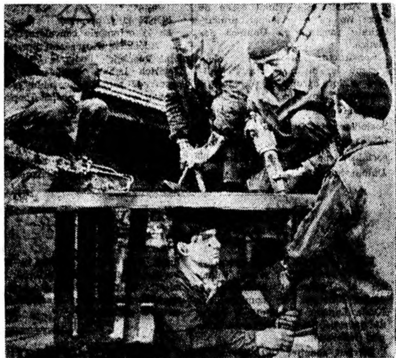
Repararea colivilor de puțuri de la mina Vulcan este incredincă echipa de lăcătuși conduse de Iacob Dionisie. Echipa execută reparațiile la timp și de calitate. ÎN CLIȘEU: Muncitorii Törő Aurel, Călugăreanu Paul, Pozsonyi Ștefan și Arodi Vilhelm lucrînd la o reparație sub conducerea șefului de echipă Iacob Dionisie.
