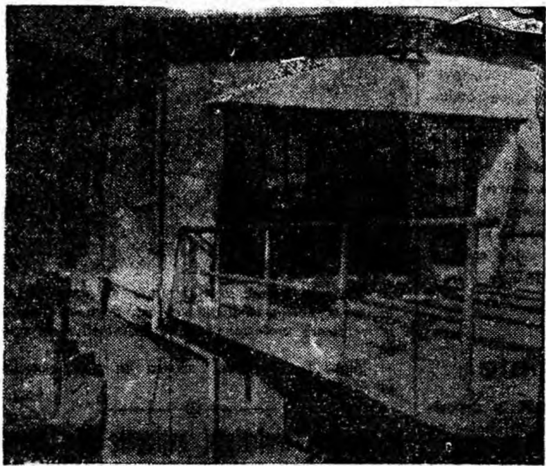
Pentru a asigura necesarul de rambleu în abataje, la mina Petrila a fost mărită simțitor capacitatea instalațiilor de rambleiere. Fotografia înfățișează culbutorul și o parte din noua pilnie de rambleu construite anul acesta la puțul est nr. 1.
