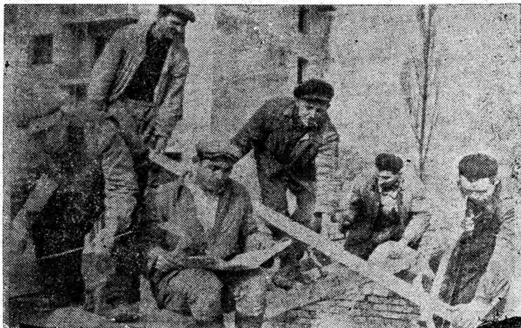
Un aspect din munca brigăzii de dulgheri condusă de Căplescu Nicolae, brigada evidenciată în întrecerea socialistă pe șantiierul de construcții nr. 10 din Vulcan.
