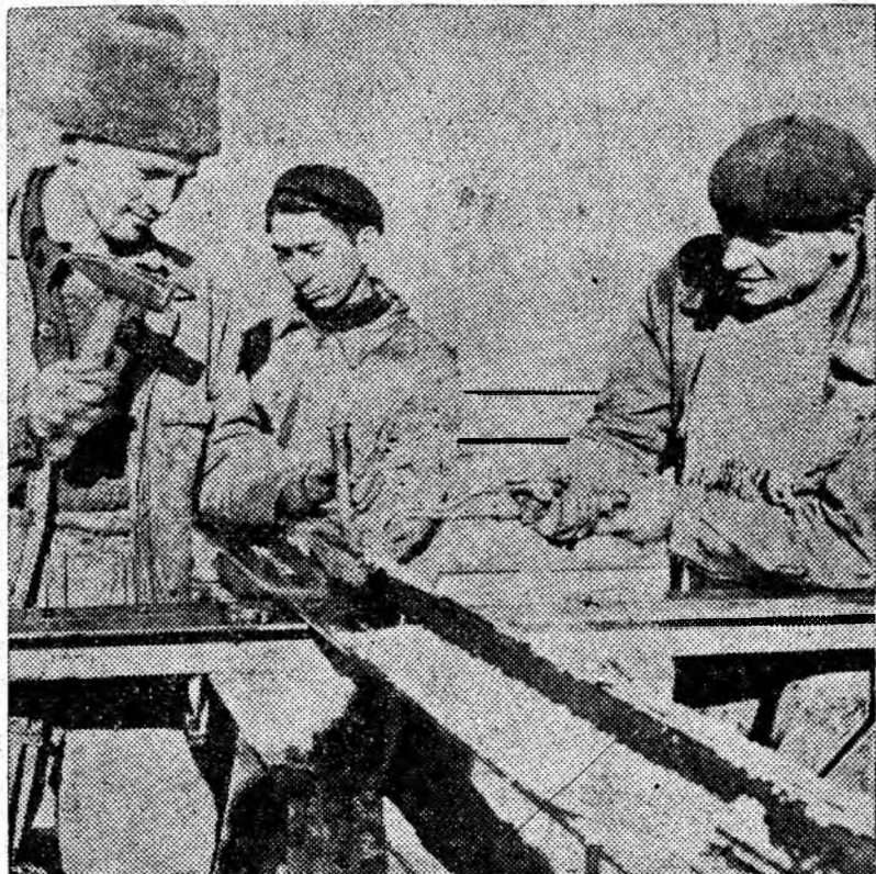
Se lucrează intens la montarea stației de acționare a funicularului de haldare a sterilului la mina Lonea.
