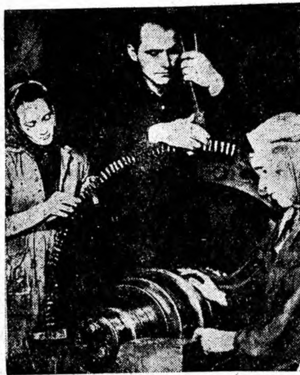
Rebobinarea puternicelor motoare electrice asincroane, cere o deosebită atenție: cea mai mică greșelă poate duce la provocarea unui scurtcircuit și arderea motorului. De aceea, tov. Burghel Mihai, Vuzdugan Catinca și Șirean A., de la S.R.E. Vulcan se străduiesc să execute numai lucruri de bună calitate.
