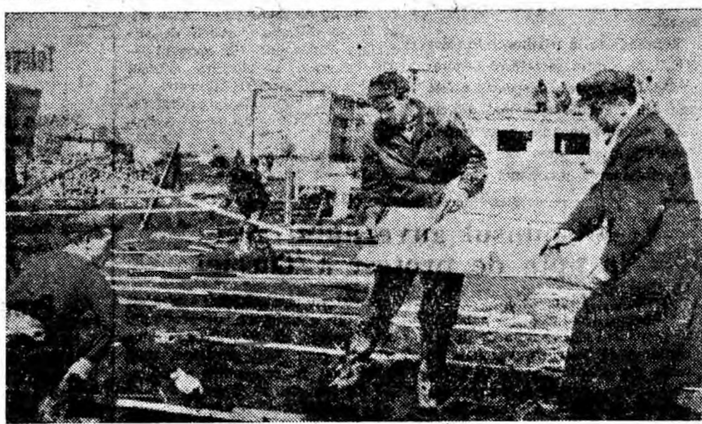
În cartierul Livezeni-Petroșani se construiesc noi blocuri. Iată în clișeu de față pe tehnicianul Prodan Augustin, împreună cu Bôhm Ioan, șeful unei echipe de dulgheri trasînd fundația unui nou bloc cu 60 de apartamente.
