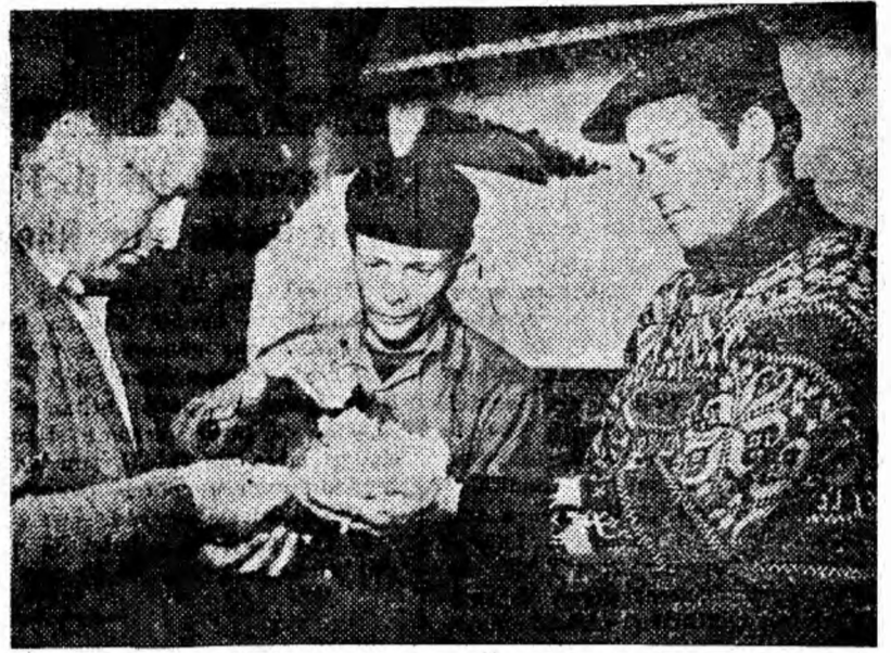
La secția I-a a Viscozei Lupeni se acordă toată atenția indicilor de calitate a alcali-celulozei puse în circuitul tehnologic al producției. IN CLIȘEU: Tov. Mateescu Ioan, ajutor maistru, Trancă Emil și Rîmniceanu Orajău verifică temperatura alcali-celulozei la descărcarea din desfibrator.
