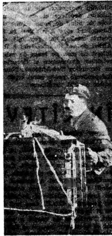
Minerul Demeter Augustin de la Dilja lucrează cu mașina nouă de încărcat E.P.M.-2, cu ajutorul căreia brigada lui sapă galeria transversală de la orizontul 565.
