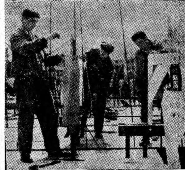
La construcția blocului turn, cu 8 etaje, de la Vulcan se va folosi metoda rapidă de lucru cu cotraj glisant, care va asigura un ritm de execuție de un etaj pe zi. Pregătirile premergătoare turnării betonului, respectiv începerii glisării, sînt ca și terminate.
