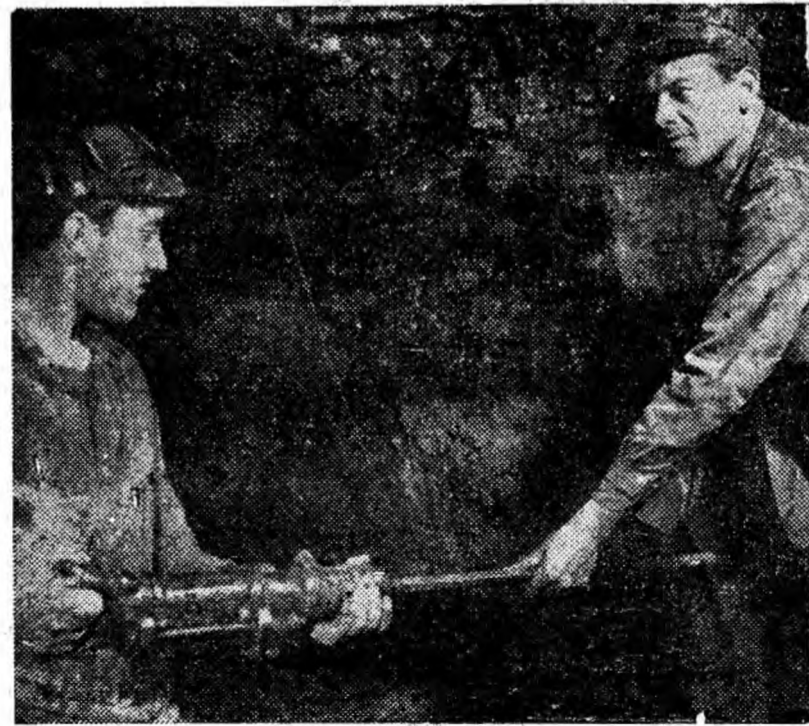
La una din galeriile de coastă de la mina Paroșeni începe perforarea frontului. Șeful de brigadă Moloci Teodor este ajutat de către unul dintre ortacii săi, minerul Toma Vasile.
