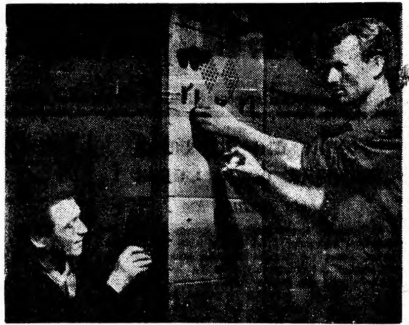
La I.C.T. Paroșeni este în curs de extindere centrala telefonică internă tip dispecer pentru deservirea noului grup electrogen de 150 000 kW. În fotografie: Tehnicianul Nîcoară Gheorghe și electricianul Negreanu Iosif controlează funcționarea aparatului instalat și a liniilor telefonice.
