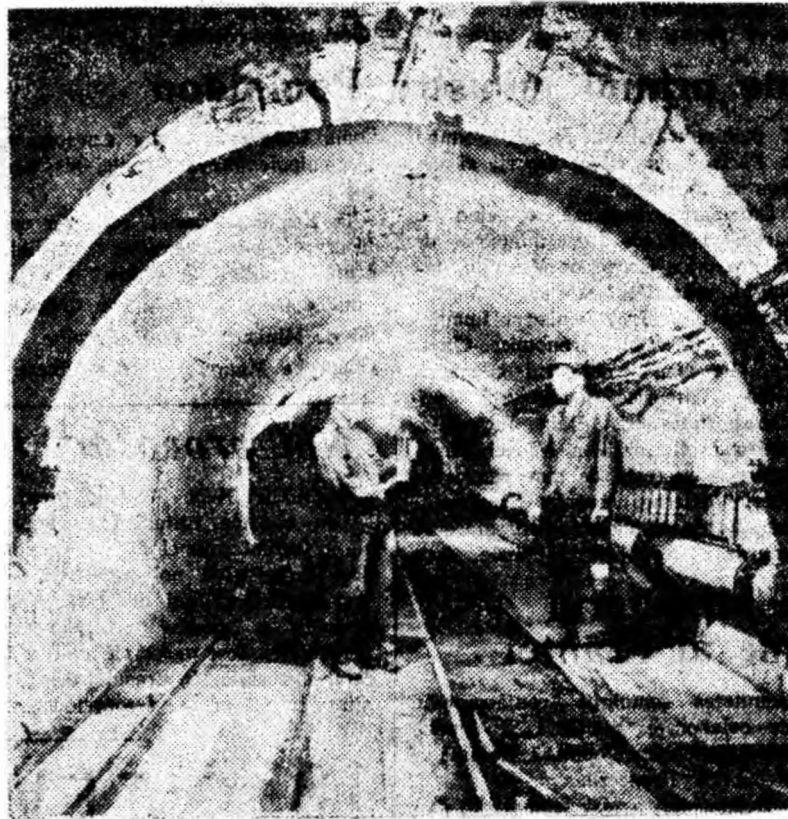
Minerii de la Dilja au creat în subteran o modernă rețea de lucrări miniere de deschidere. ÎN CLIȘEU: Vedere din galeria de transport de la puțul orb nr. 1 orizontul 607.
