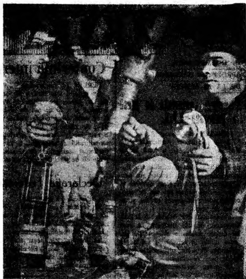
Abatajul frontal de pe stratul 18, de la mina Vulcan este dotat cu instalații utilizate miniere care ușurează mult extracția cărbunului. ÎN CLIȘEU: Lebadă Gheorghe, șeful brigăzii care lucrează în frontal (primul din dreapta) se sfătuește cu doi mineri asupra folosirii mai raționale a stîlpilor hidraulici de armare.
