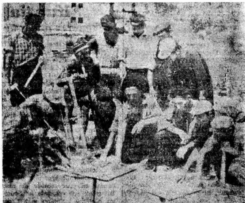
Brigada de dulgheri a lui Kiss Alexandru este cunoscută pe multe șantiere din Valea Jiului unde a contribuit la ridicarea noilor blocuri. ÎN CLIȘEU: Membrii brigăzii studiază planurile unei noi lucrări, la blocurile aflate în construcție pe șantierul Livezeni.
