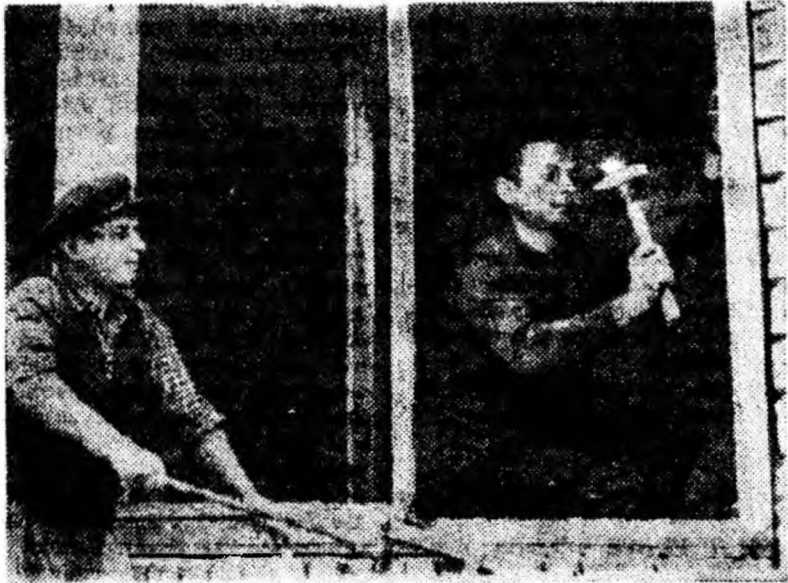
Finisajul apartamentului 2000 de pe șantierul Livezeni-Petroșani, se desfășoară din plin.
