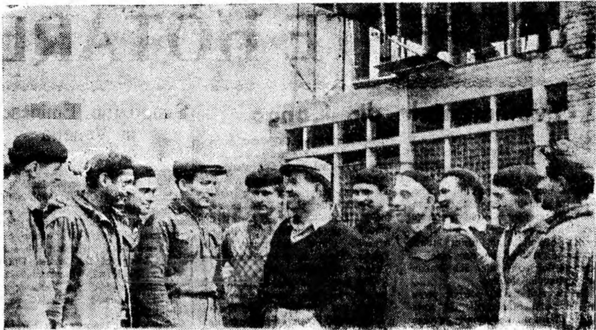
Construcția centralei termice I — Livezeni se desfășoară într-un ritm intens. O contribuție însemnată la aceasta aduc brigada de dulgheri a lui Cristea Constantin și cea de zidari a lui Huncu Ștefan, care au executat pînă acum un volum mare de lucrări.
