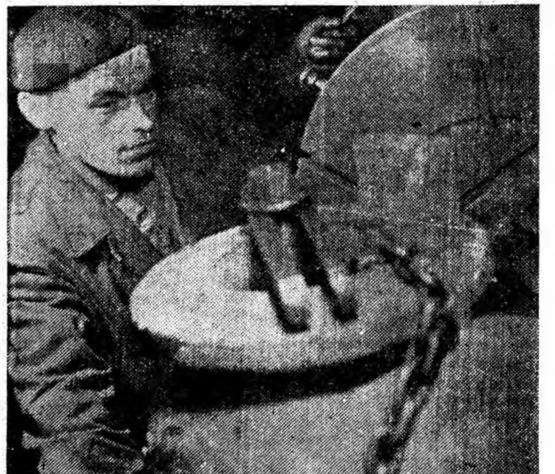
Strungarul Balog Ladislau se numără printre muncitorii harniei de la U.R.U.M.P. Iată-l strunșind un cilindru de pompă.
