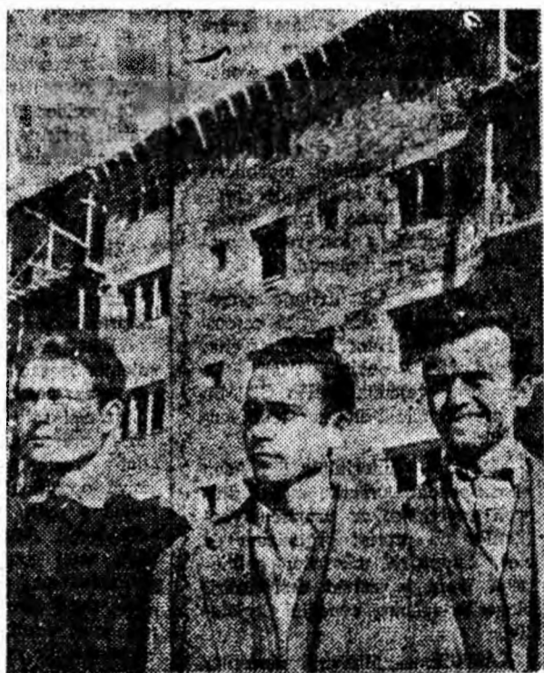
Pe șantierul Petrila, zidarii Postolache Dumitru, Postolache Nicolae și Berințan Ioan se numără printre tencuitorii evidențiați: ei își depășesc norma cu 60 la sută.
