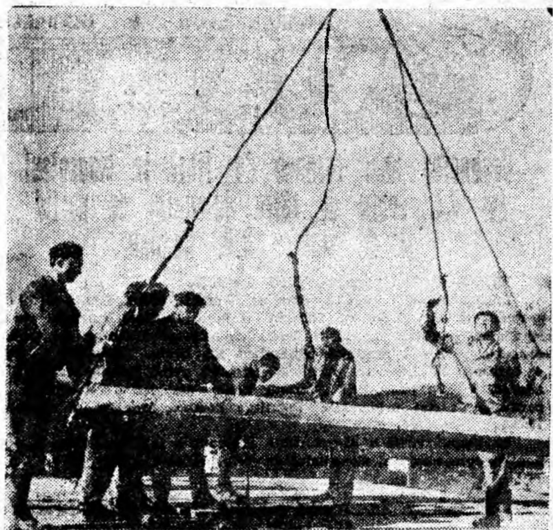
Un nou planșeu peste bloc și clădirea crește cu încă un etaj. Brigada lui Nagy Dezideriu de pe șantierul Livezeni are o mare experiență în aceste lucrări, realizîndu-le într-un timp scurt.
