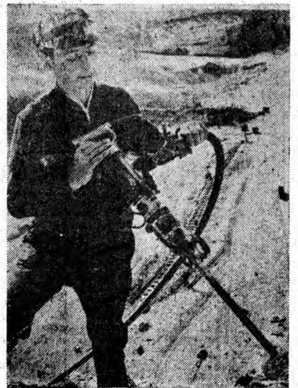
La orizontul superior al carierei Bănița, minerul Butnaru Ioan perforează noi găuri. În curînd, explozia va smulge alte sute de tone calcar siderurgic, care vor lua drumul furnalelor.
