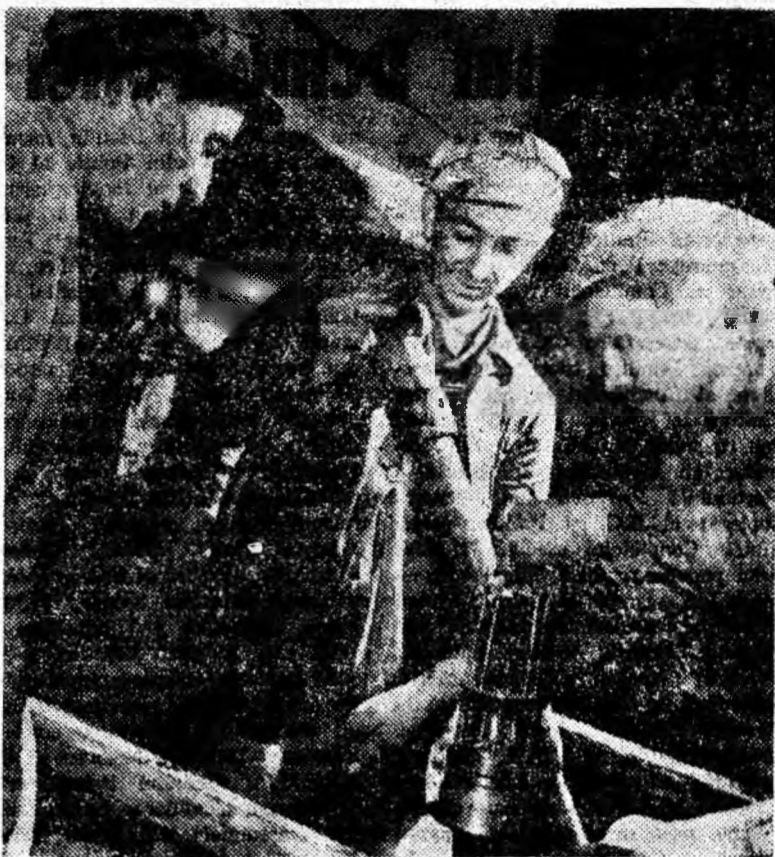
Brigada de pregătire condusă de Moloci Tudor de la mina Paroșeni deține de luni de zile întâietatea în întrecere. Iată unul din schimbările brigăzii, cel condus de minerul Rotaru Gheorghe, lucrând la betonarea canalului dintr-o galerie.
