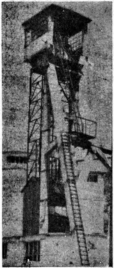
Turnul unuia din puțurile auxiliare ale minei Petrila.
