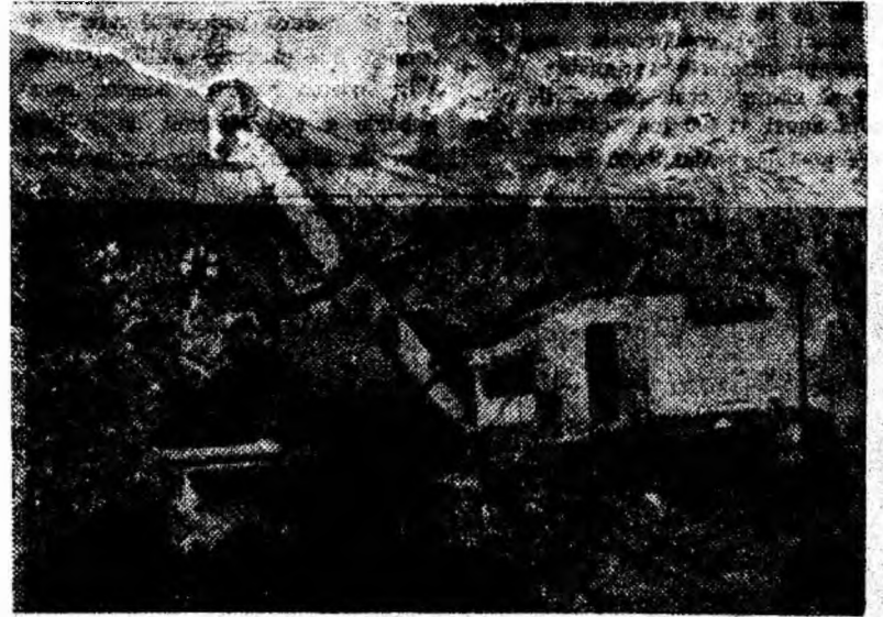
R.P.D. Vietnam. Excavator F 6 în acțiune la Exploatarea minieră de apatit Lao Cai. Volumul de pământ și piatră deplasat de echipa de muncitori a excavatorului se ridică la 700—900 metri cubi pe schimb.
