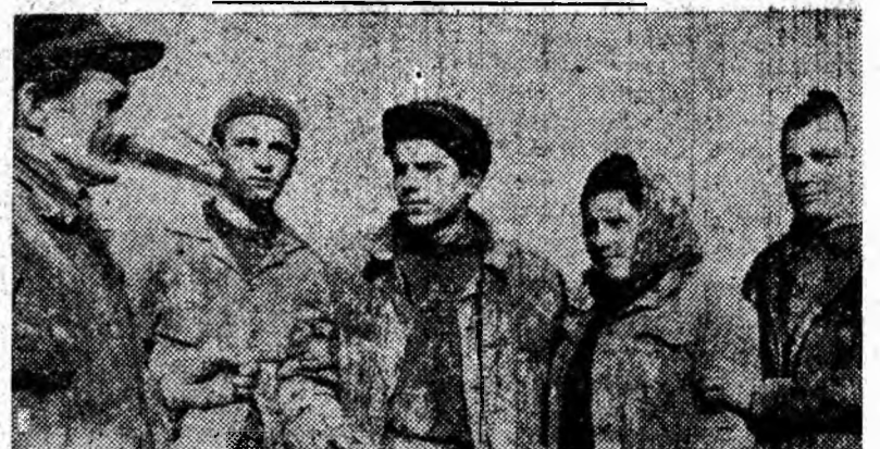
Una din echipele de frunte de la șantierul de construcții Livezeni, cea de zugrăvi-vopsitori condusă de muncitorul Ene Dionisie (în clișeu, primul din stînga).
