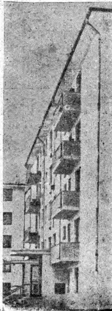
Aspect cotidian în Valea Jiului: un nou bloc! În cinstea alegerilor, constructorii șantierelor noastre vor preda încă 112 apartamente noi.
