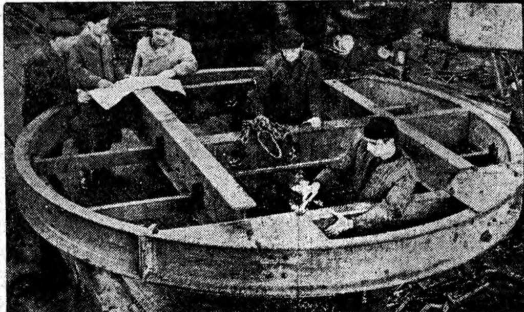
Muncitorii secției construcții metalice de la U.R.U.M.P. pregătesc pentru mina Paroșeni un pod de siguranță pentru săparea unui puț. Iată echipa de lăcătuși a lui Hantz Eugen lucrînd la asamblarea podului.
