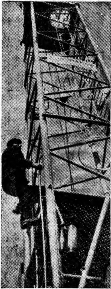
Macaraua uriașă e stăpînită de mîini sigure. Cojocarul Nicolae de la șantierul Petrila lucrează pe o astfel de macara și o străneste cu precizie.
