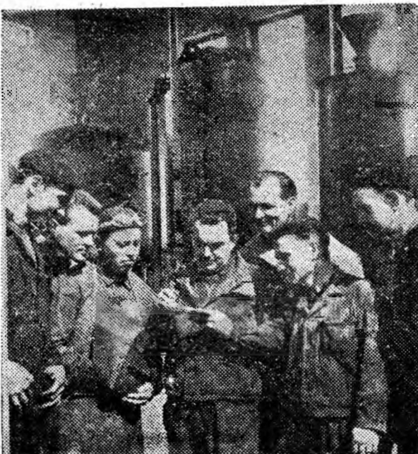
La Uzina electrică Vulcan a fost montată de curînd o instalație de preparat apă necesară cazanelor. ÎN CLIȘEU: Maistrul Pardos Dincă de la secția electrică a uzinei (în mijloc), discută cu echipa de montori problemele asigurării bunei funcționări a noii instalații.
