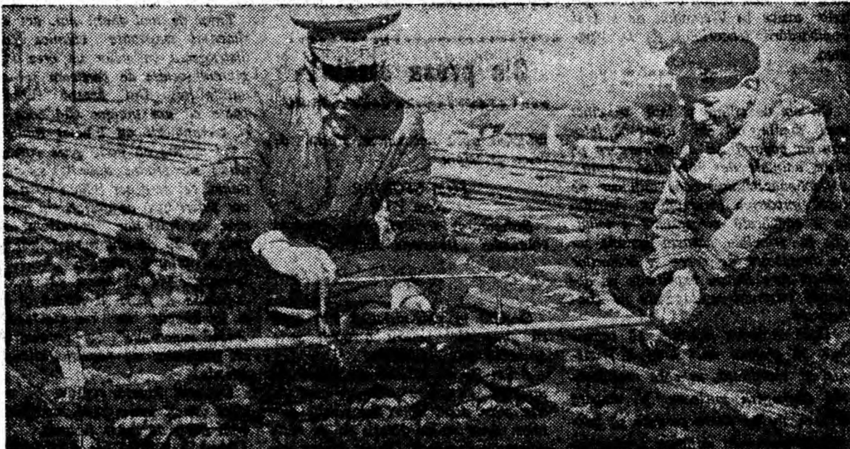
Este bună linia? Șeful de echipă Stroi Ioan de la L. 5 face un control amănunțit al liniei în dreptul cantonului 2 din stația Vulcan. La nevoie, în măsuri imediate de rectificare.
