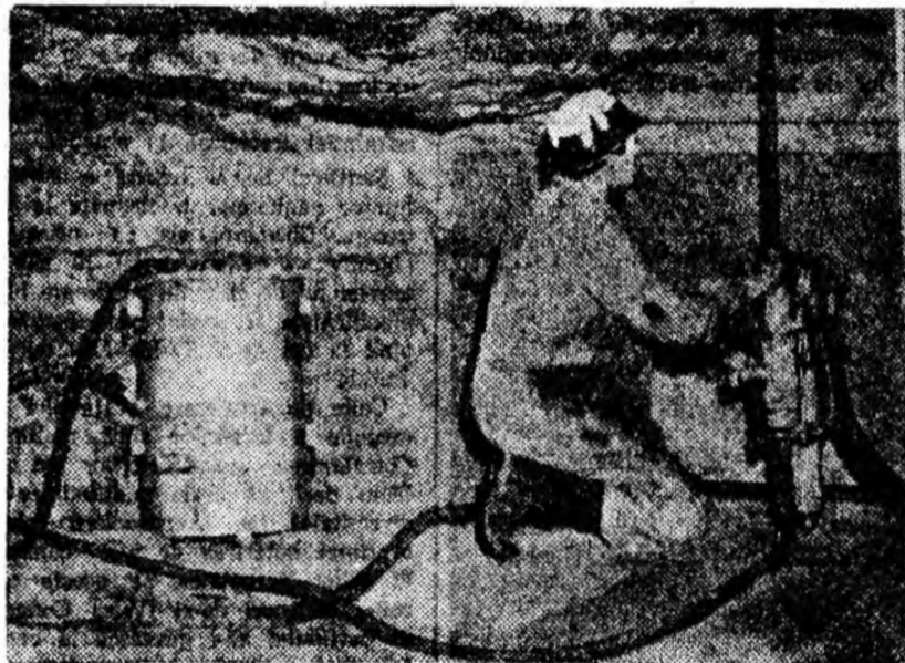
Instalația de aspirare a prafului tip Dryduetor Holman.
