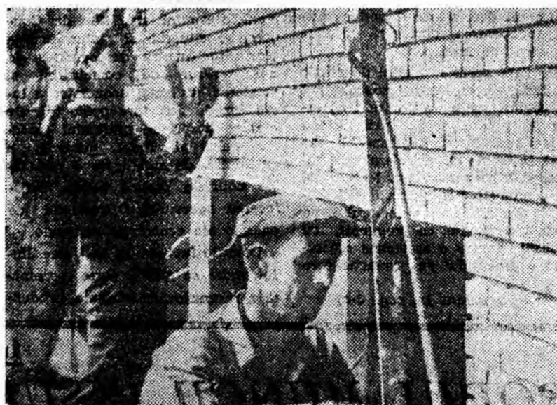
ȘANTIERUL LUPENI. Brigada de zidari a lui Avram Nicolae plachează cu plăcuțe ceramice de pe cofrajul glisant, fațada blocului D 1.
